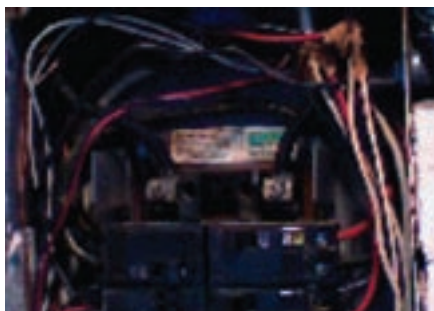
Abbildung 5-7. Eine hochohmige Verbindung bzw. eine Fehlfunktion eines Bauteils in einem Leistungsschalter im Wohnbereich ist im Gegensatz zum Sichtbild im Wärmebild klar erkennbar.
