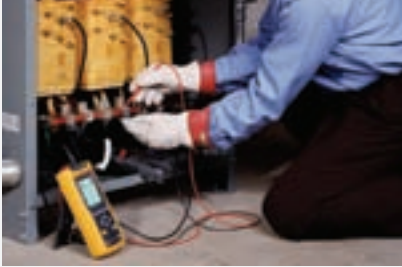
Abbildung 10-2. Bei der elektrischen Analyse werden elektrische Überwachungseinrichtungen für die Beurteilung der zum Betrieb von elektrischen Geräten bereitgestellten Netzqualität verwendet.
