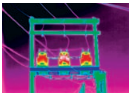
Abbildung 5-40. Ein Transformator auf einem erhöhten Geräterahmen, der wärmer als die anderen Transformatoren erscheint, kann ein Zeichen für ein potenzielles Problem sein.
