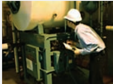
Abbildung 10-1. Instandhaltungstechniker führen regelmäßig optische und akustische Inspektionen durch und überprüfen dabei das Erscheinungsbild und die Geräusche der Betriebsmittel.
