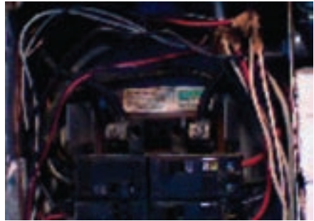
Figura 5-7. En la imagen térmica se puede ver con facilidad una conexión donde hay una resistencia alta o el funcionamiento incorrecto de un componente en un interruptor automático residencial, lo que no se puede apreciar en la imagen con luz visible.
