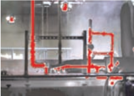
Figura 5-22. El uso de colores saturados y de alarmas de color en una paleta de grises puede resultar útil para determinar las válvulas de agua caliente y de vapor que estén abiertas y funcionando correctamente.
