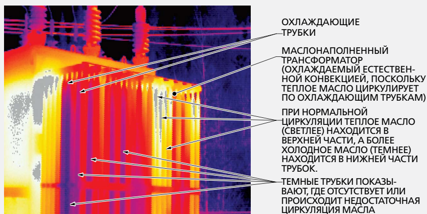
Рис. 4-2. Естественная конвекция наблюдается, когда теплое масло поднимается вверх, а холодное опускается вниз, как происходит в охлаждающих трубках масляного трансформатора.
