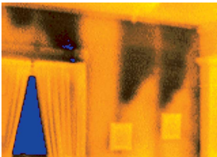
Рис. 5-69. Плохо установленная незафиксированная теплоизоляция в существующей полости стены может слезаться и стать неэффективной.
