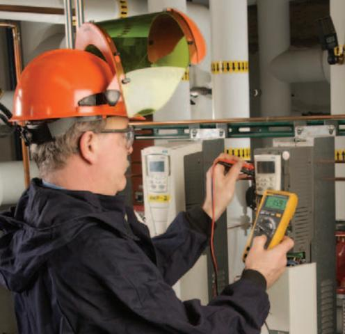
Jim Murphy, électricien contremaître, utilise le dispositif Fluke 179 DMM pour identifier les faibles signaux de tension du variateur de vitesse électrique récemment installé sur le circuit de vapeur âgé de plus de 40 ans.
