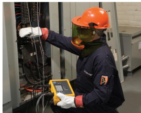
Rolf Zoeller, électricien, utilise l'enregistreur de puissance triphasé Fluke 1735 pour effectuer des études de charge des circuits électriques de l'hôpital. Cette surveillance étroite des circuits a permis à l'hôpital d'être reconnu par ENERGY STAR.
