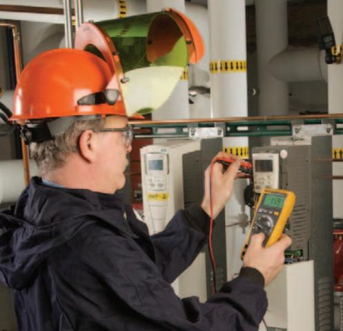
Jim Murphy, Elettricista capo, utilizza il Fluke 179 DMM per controllare i segnali in bassa tensione nel VFD appena installato per il sistema a vapore attivo da più di 40 anni.
